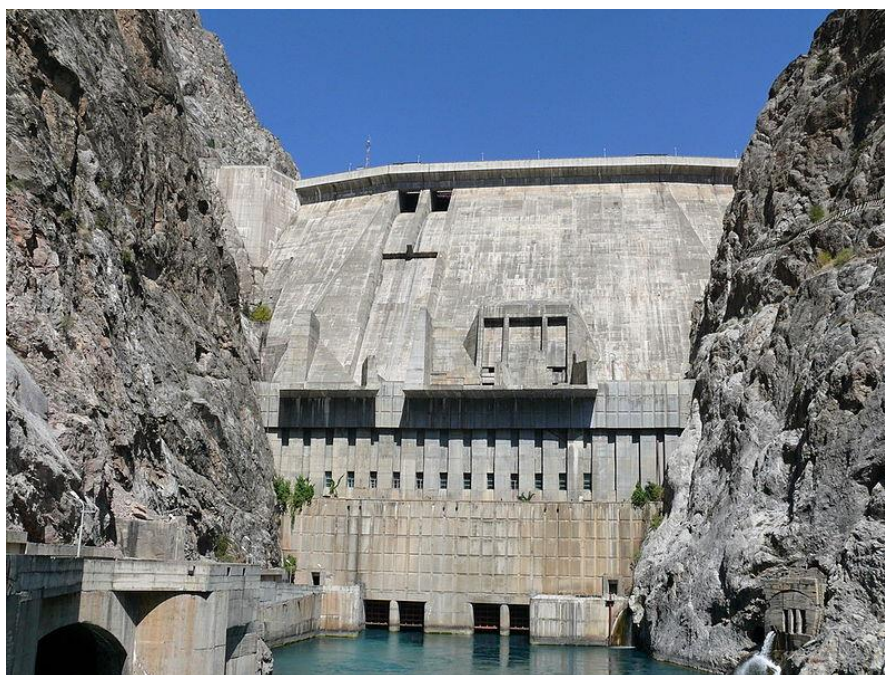
Рисунок 1. Плотина Токтогульской ГЭС
